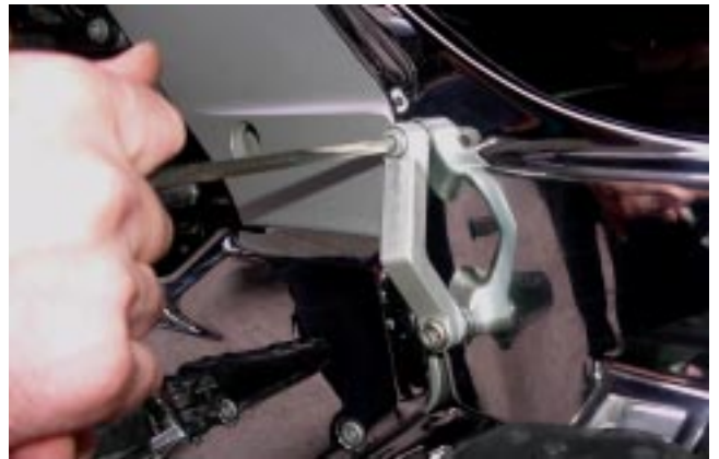
Abb .2: Fertig montierte Öse Fahrtrichtung links
